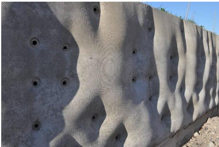
Rys. 2.5. Ściana wykonana z zastosowaniem deskowania z tkaniny, źródło: Wilf Meynell/Studio Bark [48]
