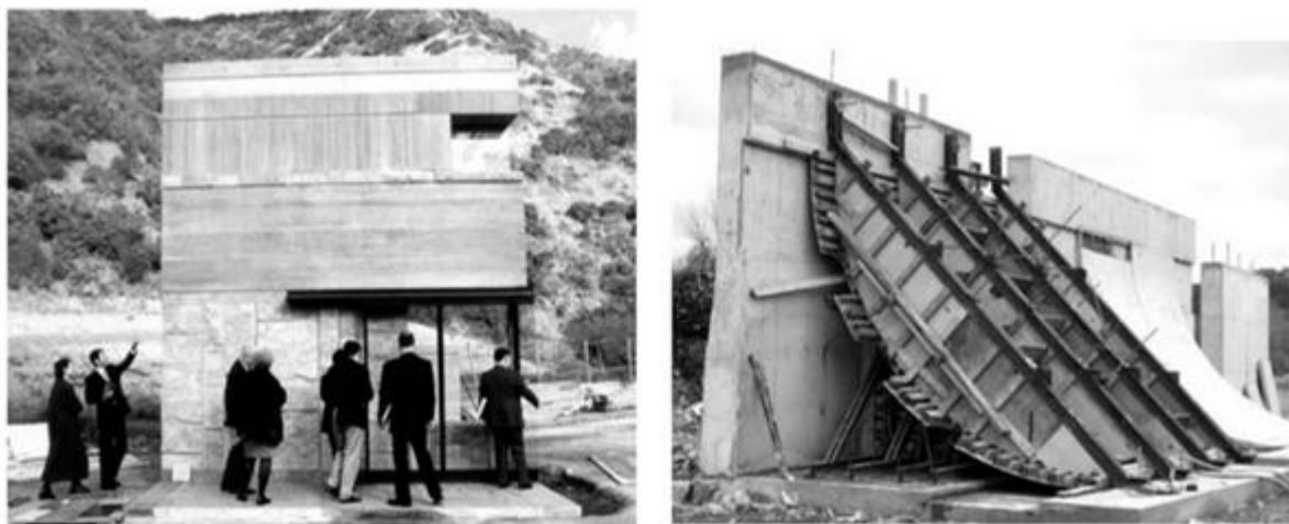
Rys. 3.1. Przykład elementu referencyjnego według wytycznych ACI 303R-12 [8]
